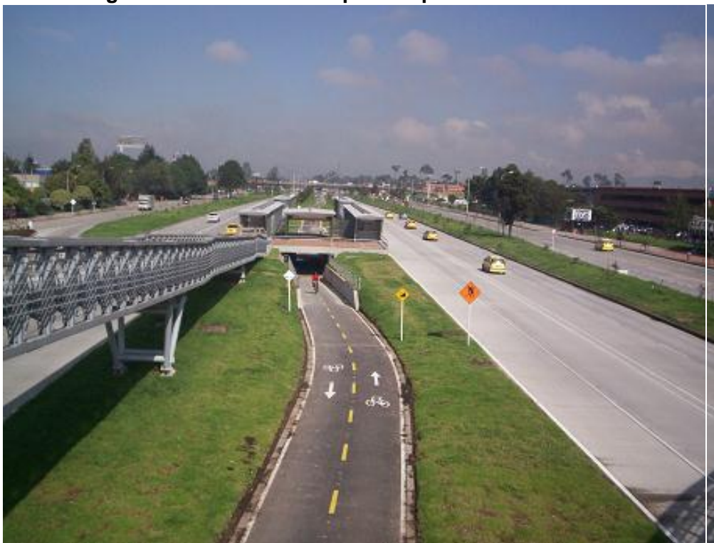
Imagen 17. Estaciones con paso deprimido de ciclorruta
