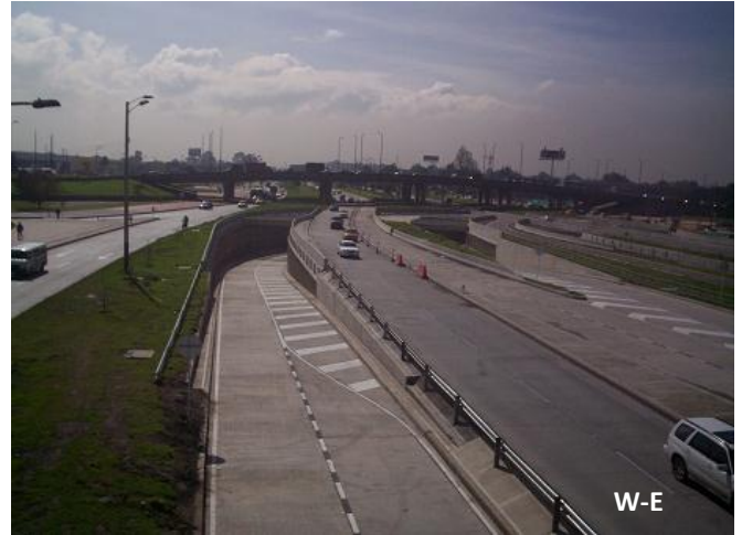
Fuente: CCB. Visita técnica de diciembre 2 de 2011. Calle 26 x Av. Cali
