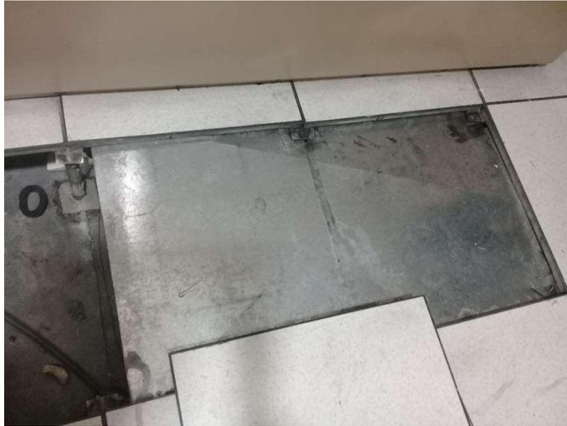
*Imagen 18. Ducto de Suministro de Aire Existente.*
