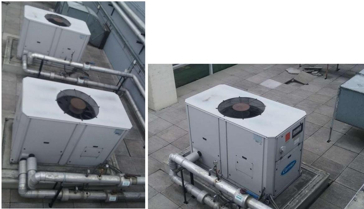
*Imagen 1. Enfriadores de Agua Existentes Ubicados en cubierta piso 9*
