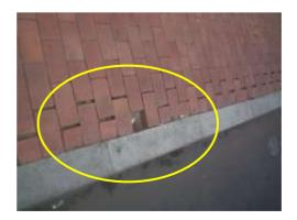
Esta obra está concluida, no obstante se identifican puntos con fallas con hundimientos que en el corto plazo puede causar un daño en toda la obras, pues el agua puede filtrarse y despegar los adoquines.
