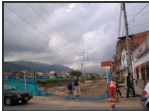
Imagen 5. Señalización y cerramiento de las obras
