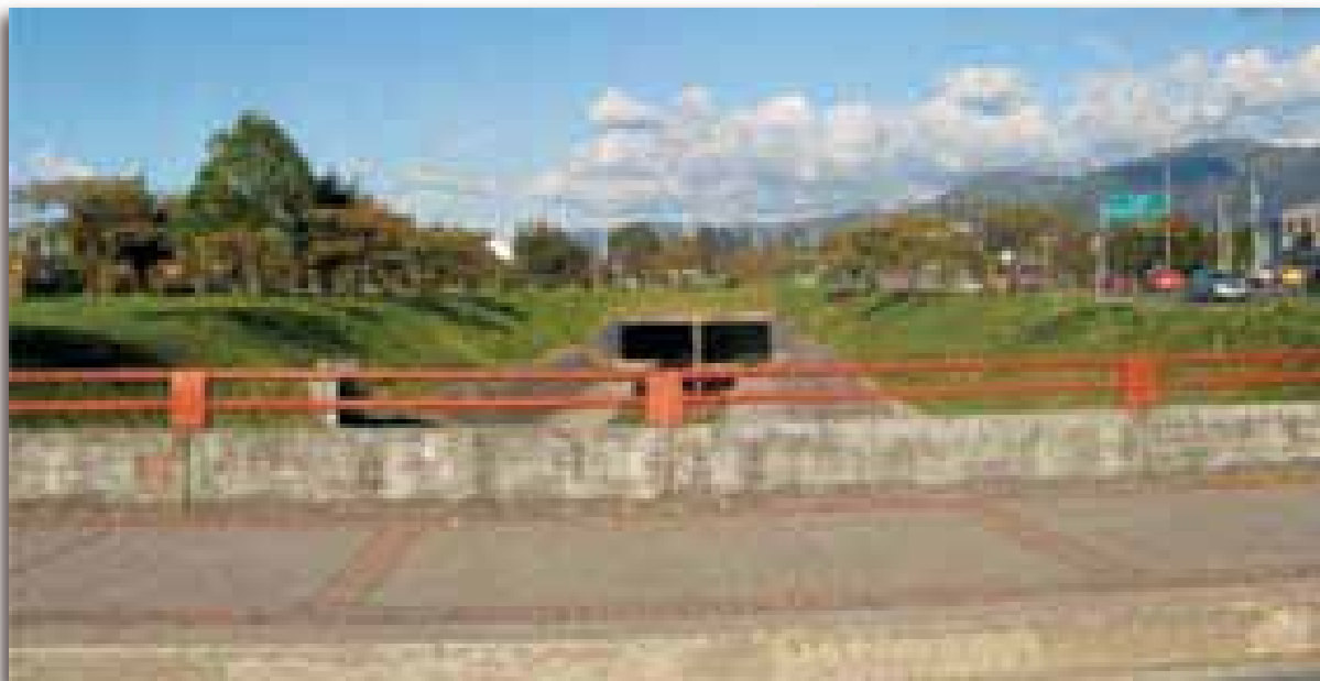
Foto 34. Zona de ronda del canal San Francisco a la altura de la carrera 68.
