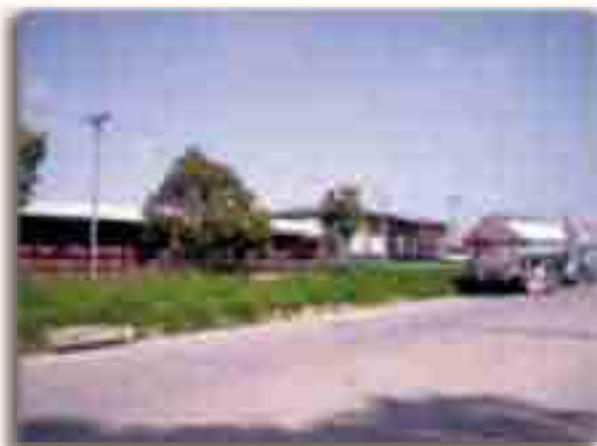
Foto 9. Almacenaje de combustibles.
