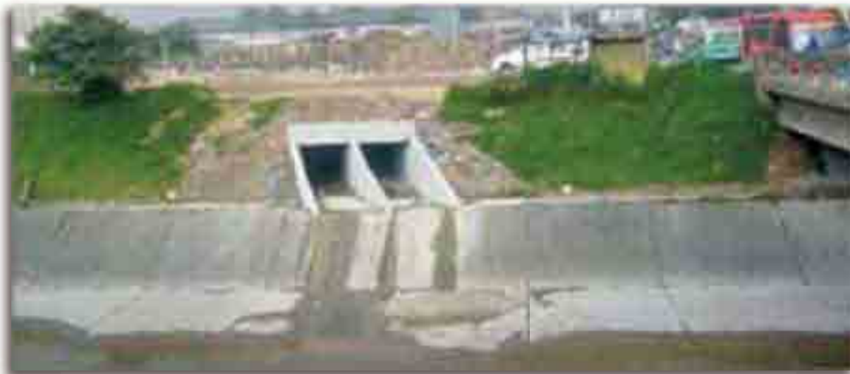
Foto 33. Vertimientos sobre el canal San Francisco a la altura de la localidad Fontibón.
